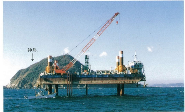
▲神島北東沖での海上ボーリング用作業台船(SEP)での調査状況(H8.1撮影)
