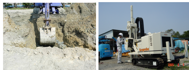
写真-1 土壌掘削状況(左)ボーリング調査状況(右)
