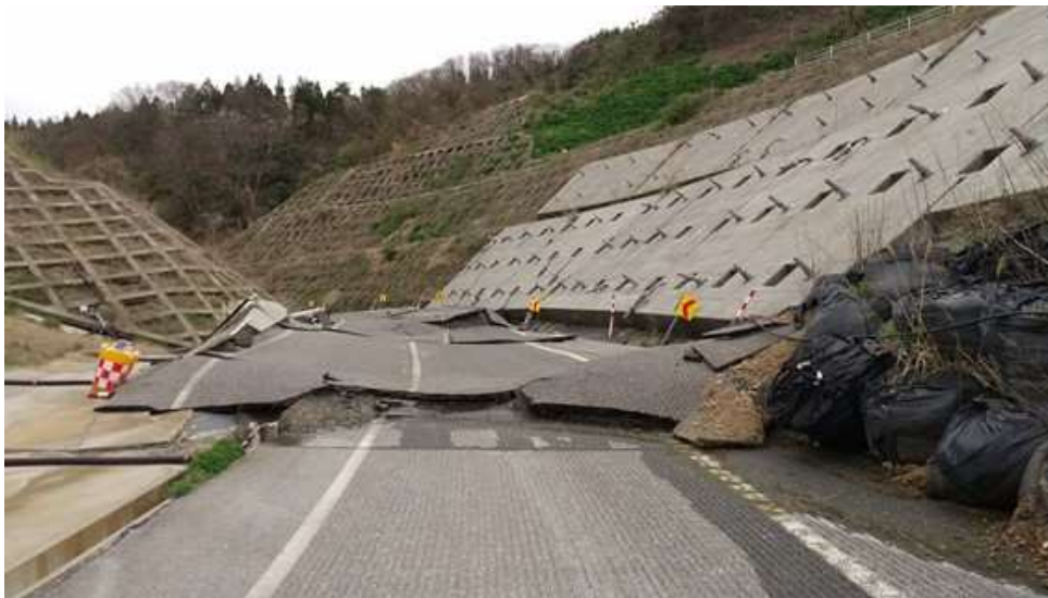
(a) 地すべり頭部の段差亀裂①の状況 (b) 地すべり頭部の段差亀裂②の状況
