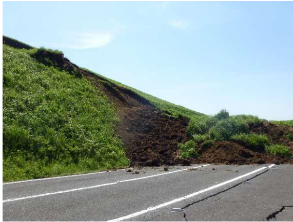
のり面の崩落
