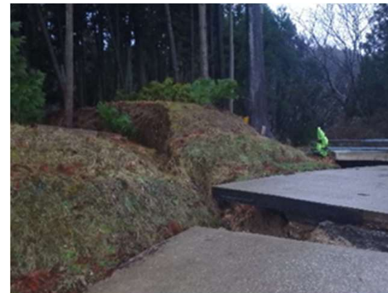
(a) 地すべり頭部の段差亀裂①の状況 (b) 地すべり頭部の段差亀裂②の状況
