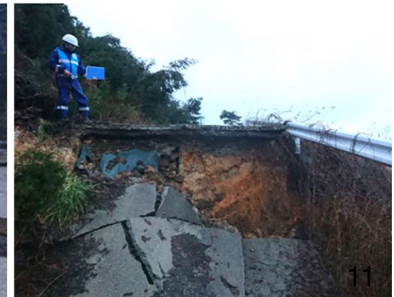
(a) 地すべり頭部の段差亀裂①の状況 (b) 地すべり頭部の段差亀裂②の状況
