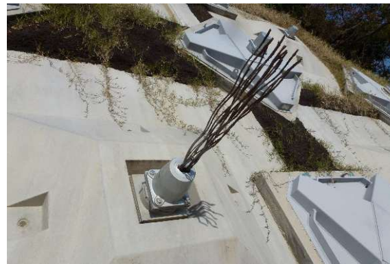
アンカー緊張部の破断
