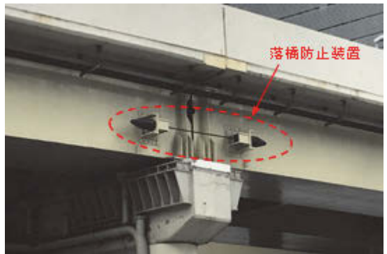
地震で橋が落ちない対策 (日本デザイン振興会に加筆)
