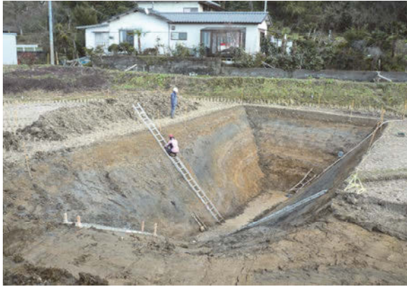
熊本地震のトレンチ調査
