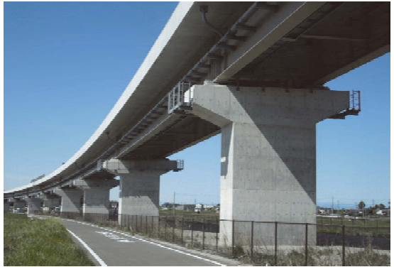
日本の橋の太い柱
