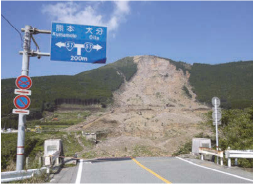
熊本地震で壊れた阿蘇大橋
