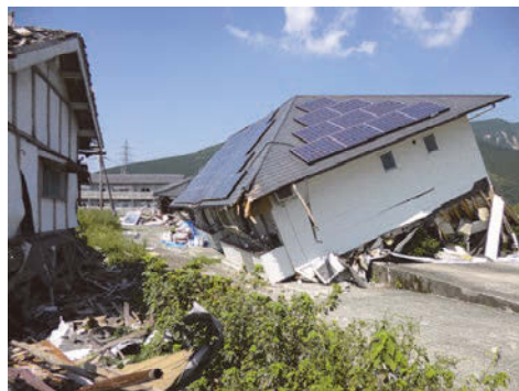
熊本地震で倒れた家屋
