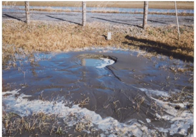
千葉県東方沖地震によるクレーター状の噴砂跡 (応用地質)
