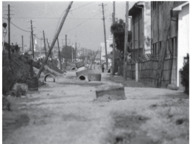
新潟地震によるマンホール・下水管の浮き上がり (応用地質)
