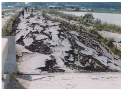
日本海中部地震による 堤防の液状化被害 (応用地質)
