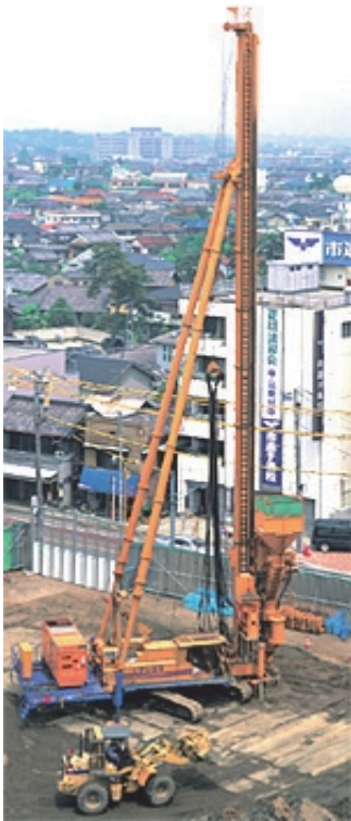
液状化対策の例 (SAVE コンポーザ工法 研究会)
