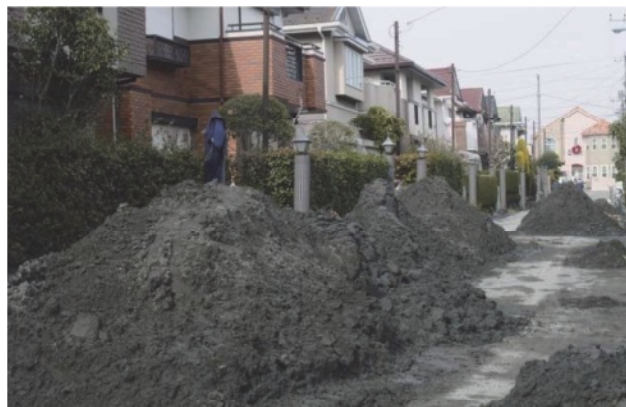
東日本大震災における浦安市内の噴砂 (地盤工学会 HP)
