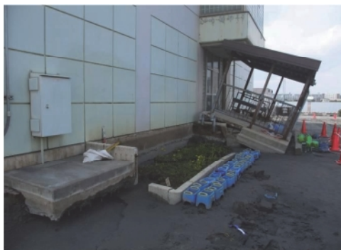
東日本大震災による 建物の抜上りと傾いた昇降口 (地盤工学会 HP)
