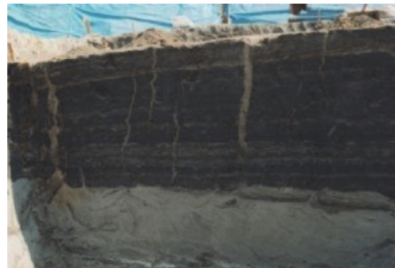
西鴻池遺跡の液状化跡 黄色く縦に伸びる筋が噴砂 (京都大学防災研究所 HP)
