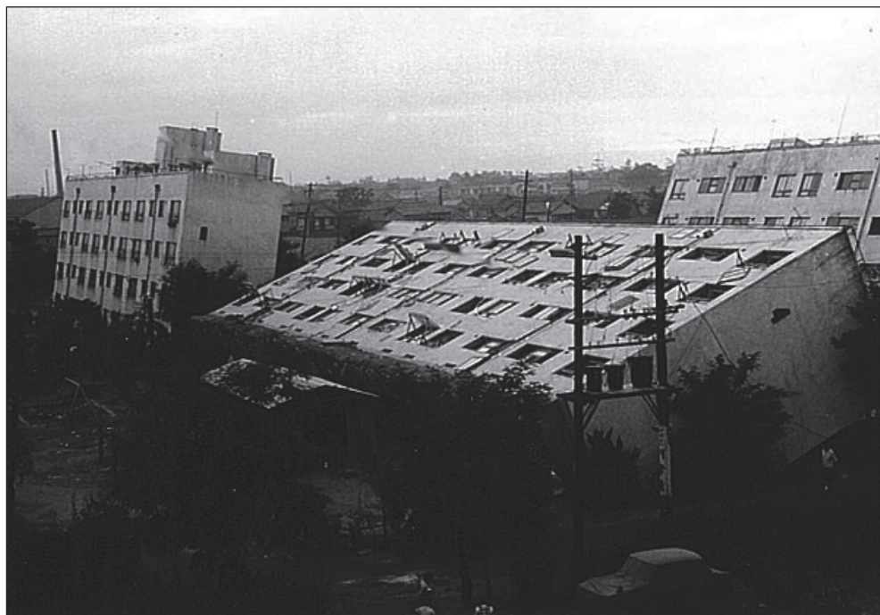
新潟地震の液状化で転倒したアパート(1964年6月)
