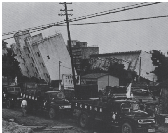
新潟地震の液状化によるアパートの転倒 (新潟県土木部)
