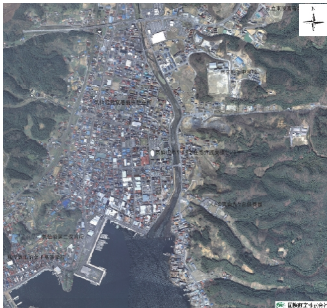
地震発生前(2009.5)の気仙沼港の様子
