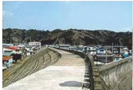
宮古市田老地区防潮堤 (国交省釜石港湾事務所HP)
