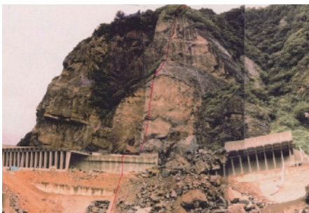
玉川岩石崩壊事故(福井県)
