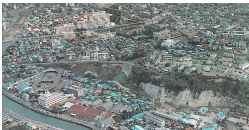
神奈川県横浜市の急傾斜地(建設省土木研究所砂防部資料)
