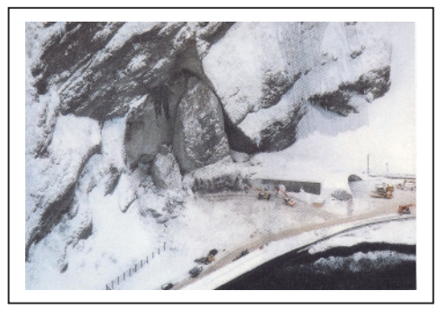
豊浜トンネル岩盤崩壊事故(国土交通省)
