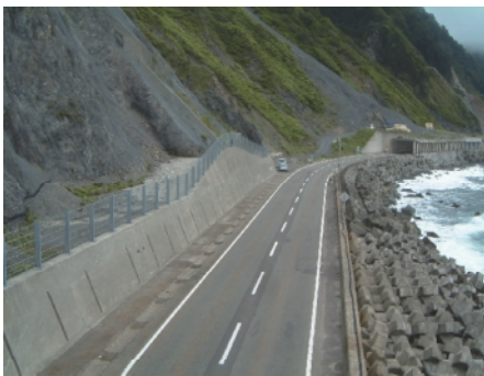
落石防護柵とロックシェッド
