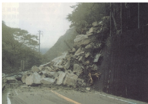
がけ崩れによる道路災害(国土交通省)
