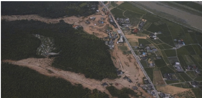
山口県防府市の土石流(国土交通省砂防部 HP)
