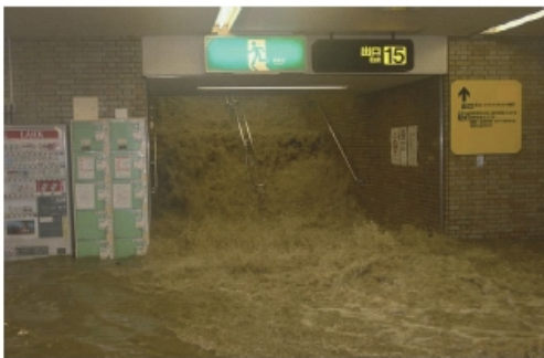
内水氾濫に見舞われた地下鉄博多駅 (国土交通省九州地方整備局 HP)
