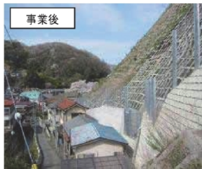
がけ崩れ対策(東京都建設局 HP)
