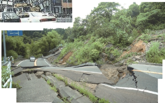
中越沖地震で寸断された道路
