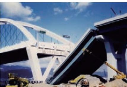
液状化による地盤の側方流動と落橋
