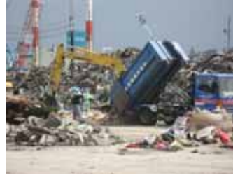
瓦礫除去;仮置き場へ
