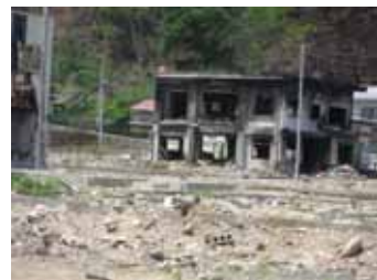
田老町の被災状況2011.06
