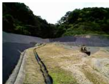
最終処分場の埋立作業
