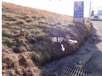
川裏側のり尻付近(3/16)
