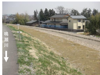
川裏第1小段の状況 (上流側: 12.3k付近から, 4/15)
