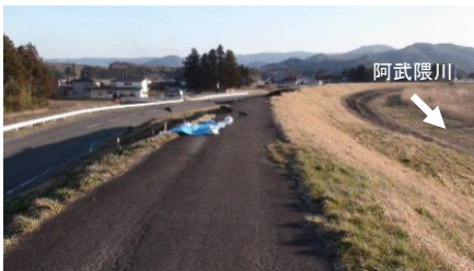
天端の状況 (32.8kp付近から上流側を望む, 3/18)
