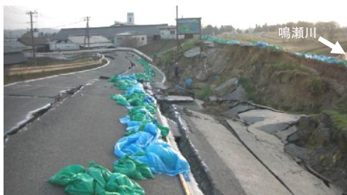
堤防天端~川裏側のり面の状況 (4/15)
