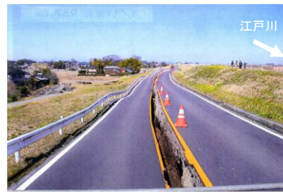
川裏側のり尻部の状況(関東地整提供)
