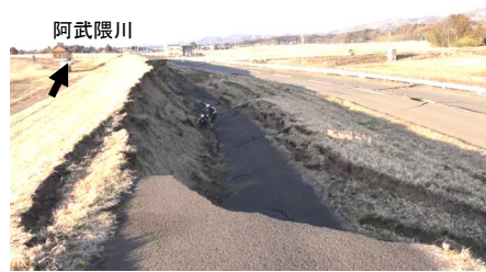
天端の状況 (33.0kp付近から下流側を望む, 3/18)
