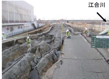
天端(市道兼用堤防)の状況(3/17) 2)
