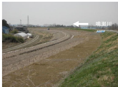
川裏第1小段の状況 (下流側: 12.3k付近から, 4/15)
