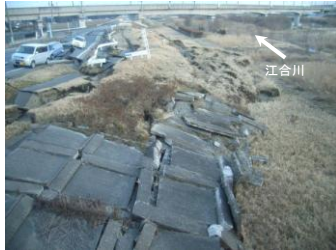
天端～表のり尻の状況 (3/12)
