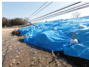
裏のり尻付近(3/18)
