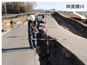
天端の状況(22.6kp付近より上流側を望む, 3/18)
