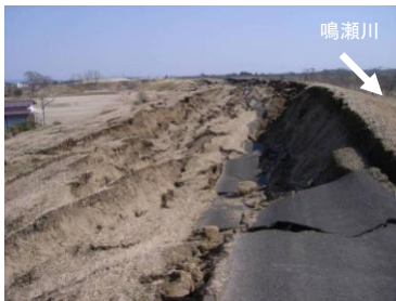
堤防天端~川裏側のり面の状況
