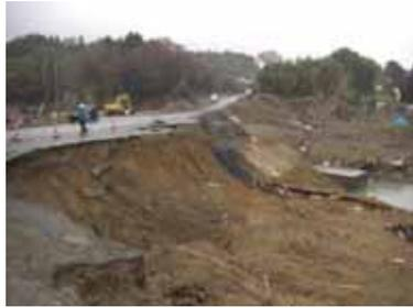
写真31 津波による盛土の被災
