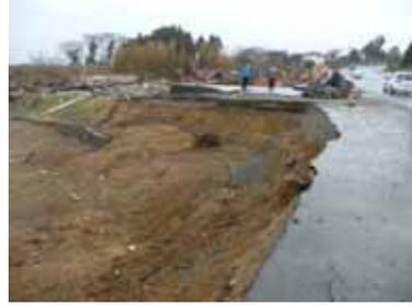
写真32 津波による盛土の被災
