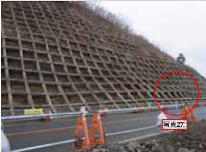
写真26 津波による現場打ちコンクリートのり枠工の被災現場
