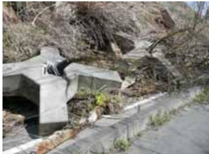
写真19 被災したグラウンドアンカー工
