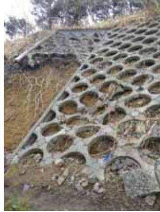
写真24 プレキャストのり枠工の被災状況
