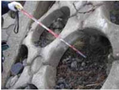
写真25 プレキャストのり枠工背後の土砂流出による隙間
