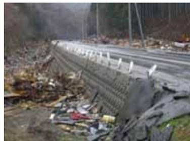
写真34 津波が襲来した道路盛土側面のコンクリートブロック積擁壁
