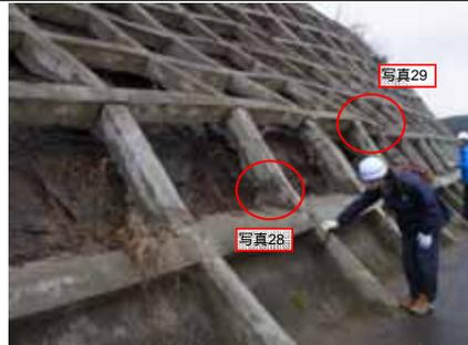
写真27 コンクリートのり枠工の被災状況
