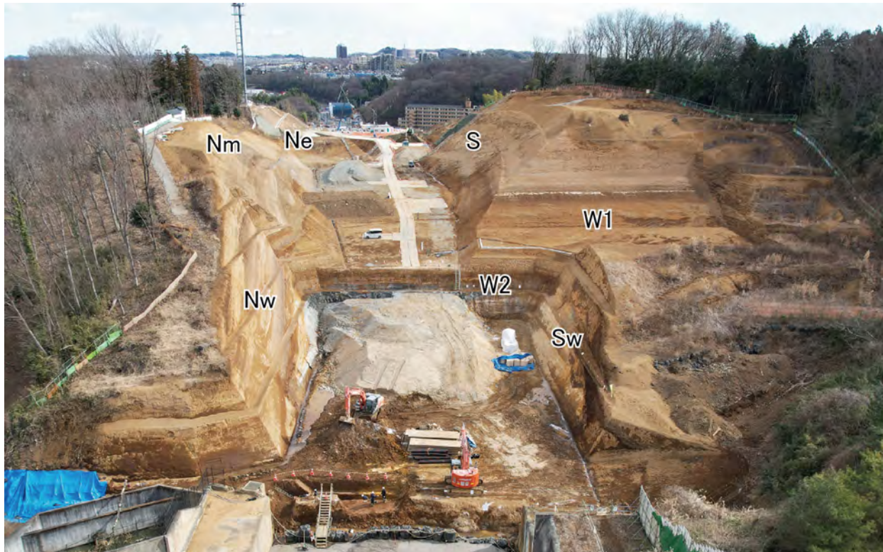
写真1 工事のり面の全景 (西から東をみる) のり面の仮称。北側のり面西部 (Nw), 中央部 (Nm), 東部 (Ne), 南側のり面 (S), 南のり面下部 (Sw)。西側のり面 (W1) と低いり面 (W2) 写真は国土交通省撮影のドローン写真
