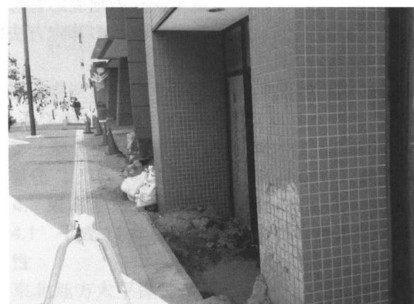
写真2 沈下した直接基礎建物（手前）と周辺地盤との間に段差を生じた杭基礎建物（奥）
