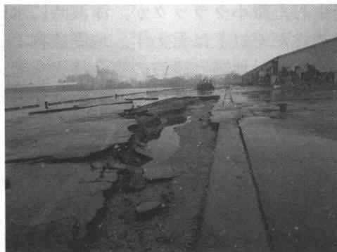
写真1 被災したエプロン舗装の変状（石巻港）
