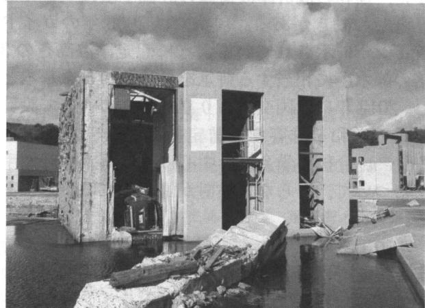
写真4 RC造建物の転倒被災事例
