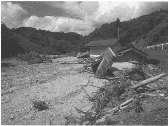
写真5 篠堂川の河床上昇と流水による家屋被害
