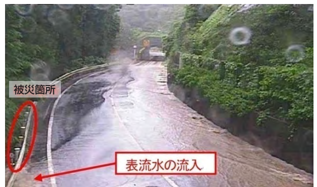
写真2 写真1の現場における災害直前の表流水の状況（管轄事務所提供） 4)
