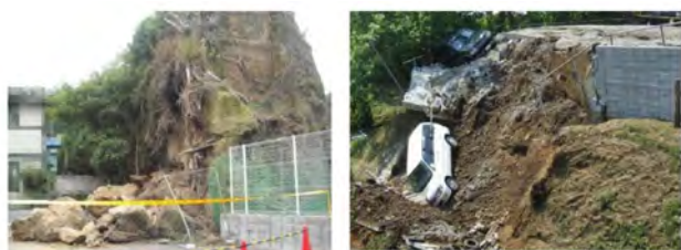
図8 崩壊事例（左：切土斜面、右：CB盛土）
