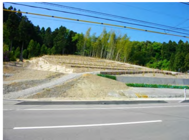
写真6 施工後の状況
