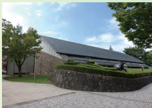
博物館の外観 (擁壁にウミユリの化石が埋め込まれている)
