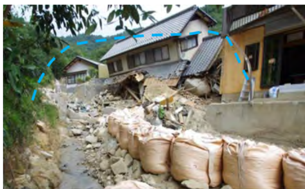
図-4 谷の出口付近の住宅の破壊。住宅の破壊は溪流に面したところだけ。最上流の住宅は被災していない。破線：土石流の洪水位。
