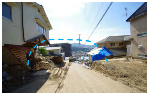
図-5 住宅地内の土石流の流下痕跡。大蛇の形態は保たれている。破線：土石流の洪水位。
