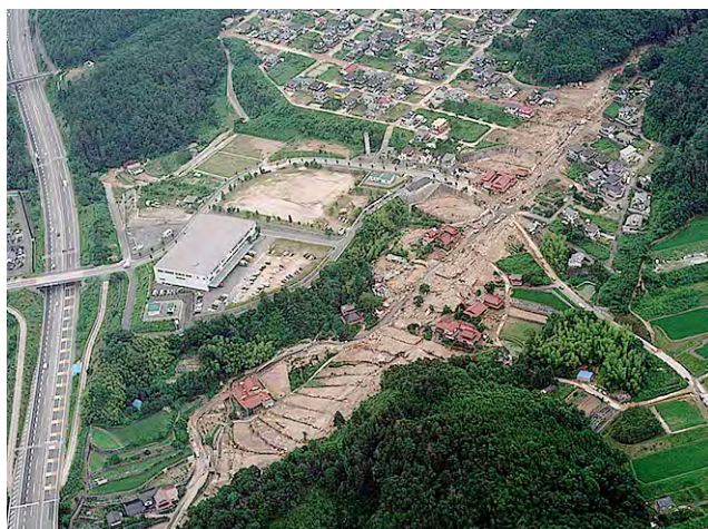
図 1 平成 11 年 6 月 29 日の広島土砂災害の状況 (撮影：アジア航測株式会社)
