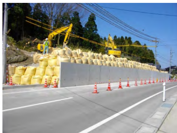
写真3 末端部の押さえ盛土
