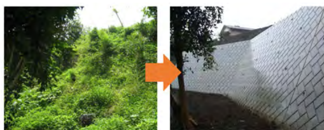
図 10 がけ地防災対策工事助成金を活用した改善
