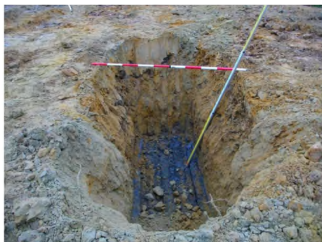
写真4 すべり面のトレンチ掘削
