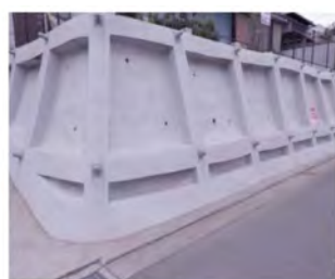
図 11 法枠による補強工事例
