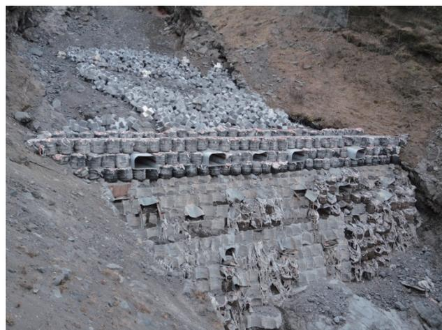
写真3 ヘリコプター施工による横工
