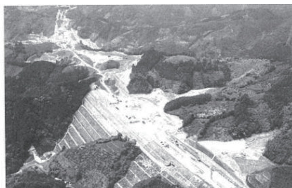
図-6 新東名高速道路の盛土 15)
