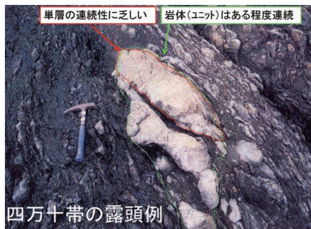
写真-10 地層の連続性が乏しい露頭
