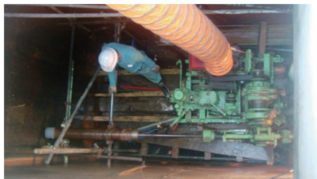
写真3 作業状況 (上方開口部より撮影)
