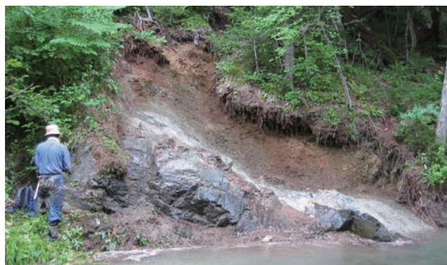
写真-6 表土剥ぎで露出した断層破砕帯
