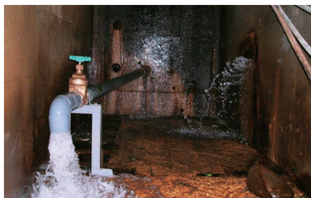
写真5 施工後 排水状況
